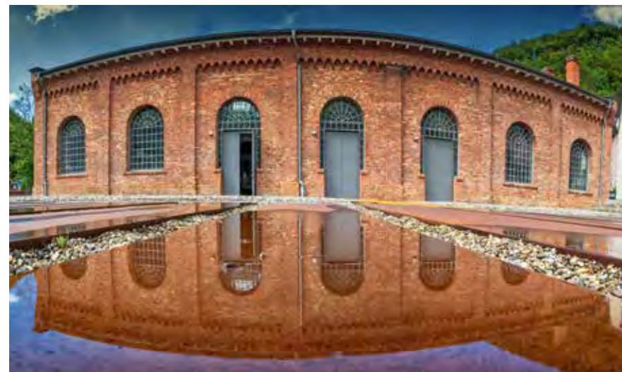
Die Krupp'sche Halle aus Backstein wurde vom Krupp Konzern als Maschinenhalle 1908/09 als letztes auf der Sayner Hütte erbaut.
